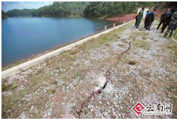
图 8.1 裂缝险情
