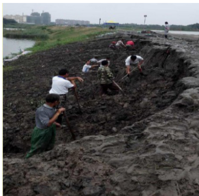
图 4.2 削坡减载
