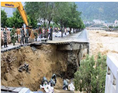
图 5.3 填塞封堵
