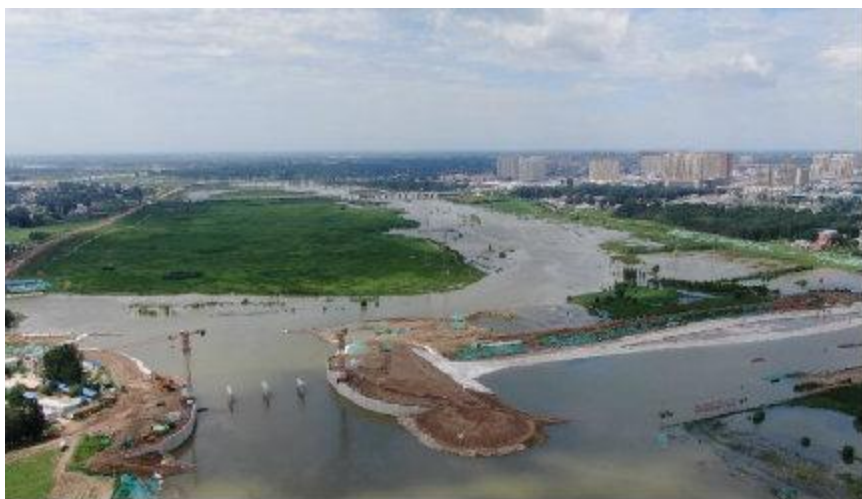
大清河新盖房枢纽分洪(马丁 摄)
